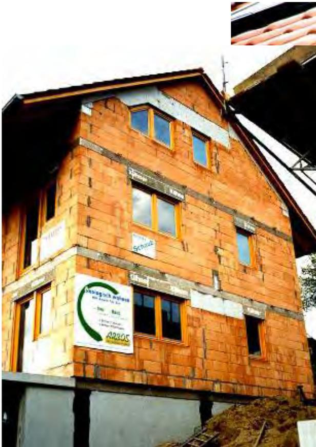
Dämmstoffstreifen an Deckenstirn
