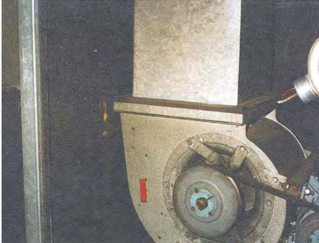
Auskleidung eines Lüftungsgerätes 20 mm Glasfaser, 30 Jahre alt. Messung bei laufendem Gerät nahe Zuluftöffnung
