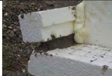
Bild 2: Polystyrol WDVS – keine fachgerechte Verarbeitung (vom Bauleiter nicht beanstandet) überbreite und unsachgemäß geschlossene Fuge
