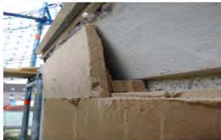
Bild 5: Wärmebrücke im Traufbereich! Holzweichfaser-WDVS wurde unsachgemäß angebracht, Detailaufgabe schlampig gelöst.
