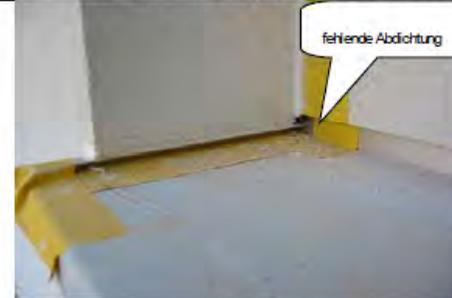
Bild 4: Fehlerhaftes Eck-Detail! Der Anschluss WDVS/Fensterrahmen/Fensterbrett ist nicht schlagregendicht ausgeführt, Feuchterisiko!
