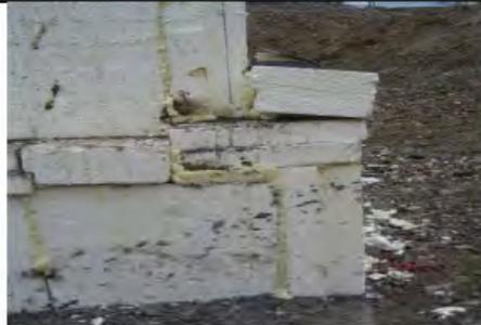
Bild 1: Polystyrol WDVS im Perimeterbereich - schlampig und lückenhaft verlegt, Stückwerk statt fachrechtem Plattenverbund
