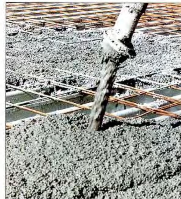
$\lambda = 0,09 - 0,18 \text{ W/(mK)}$ ;  $\mu\text{-Wert} = 7$ ; Druckfestigkeit =  $0,2 - 1,5 \text{ N/mm}^2$ , Wasserdicht
