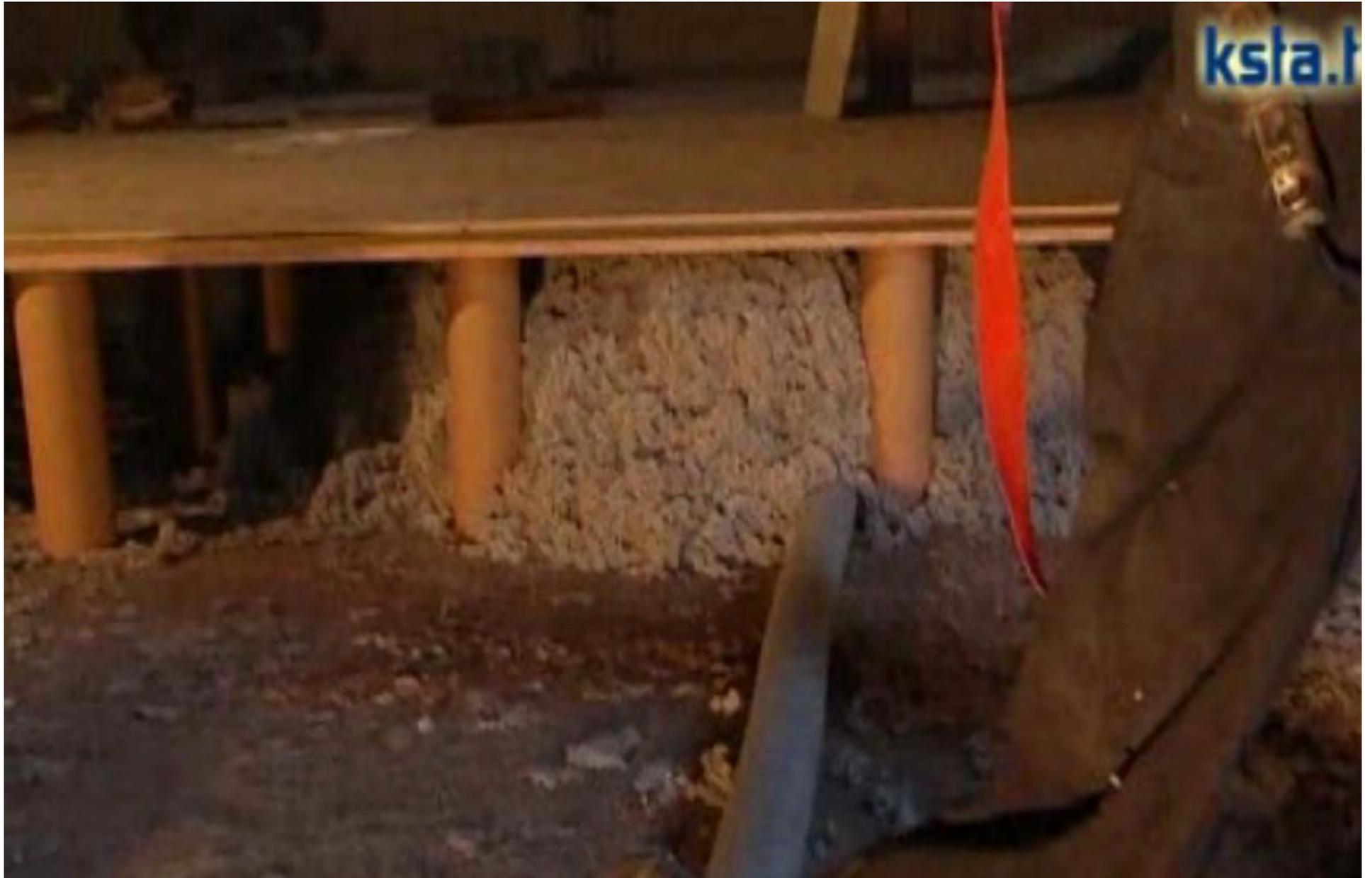
■ Schüttung: Blähton bei 1.200 Grad gebrannt.  $\lambda$ -Wert bei 0,08-0,09 W/(mK), A 1
