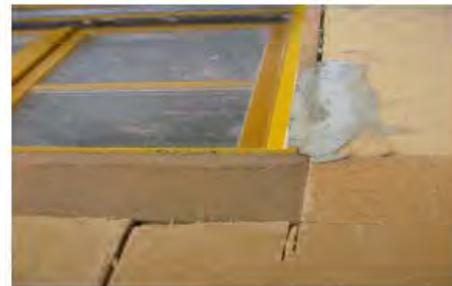
Bild 6: Holzfaser-WDVS schlampig verarbeitet und lückenhaft verlegt, kein fachgerechter Plattenverbund. Wärmebrücken!
