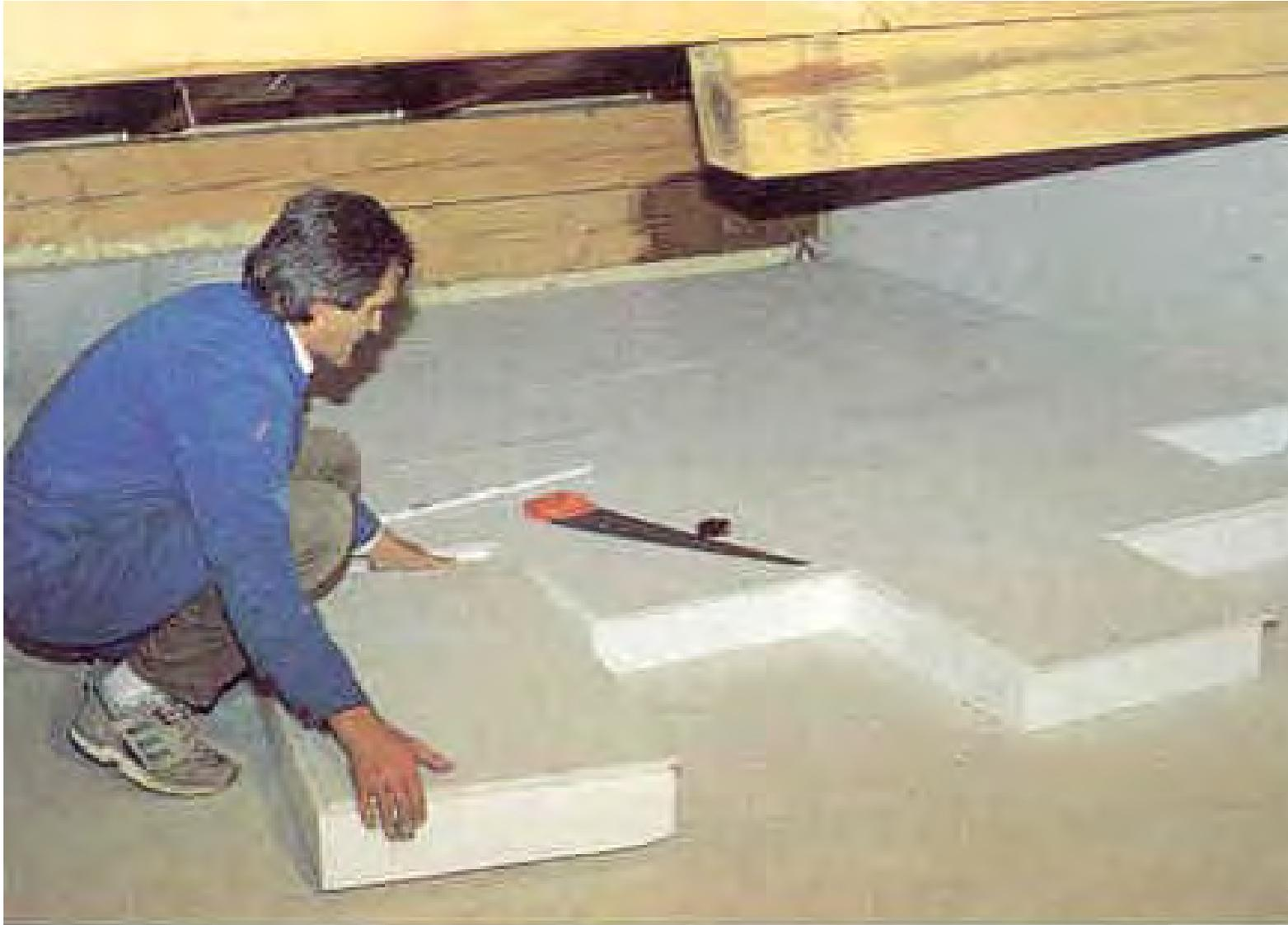
■ Neuer Dämmstoff: NEOPOR mit 0,035 W/(mK) Nennwert
