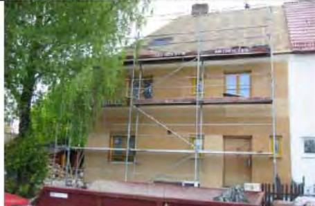
Bild 3: Brandschutzvorschriften missachtet! Holzweichfaser-WDVS (B2) wurde über die Brandwand geführt (s. Brandschutz)
