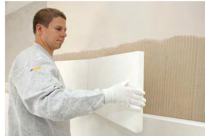
**Vakuumdämmung 0,007 W/(mK)**
